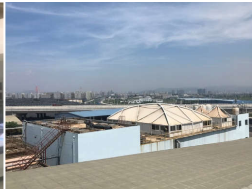
污水处理站全景
