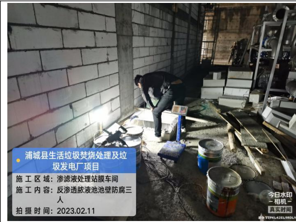
渗滤液处理站
