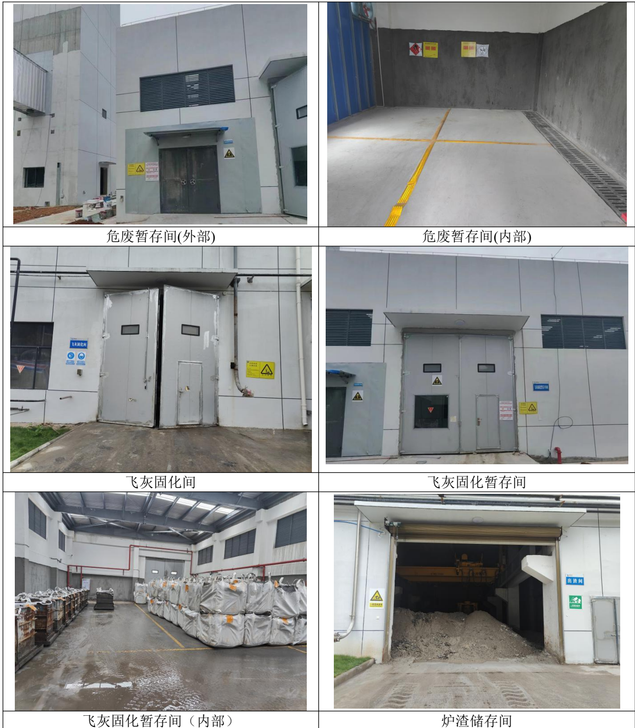
图 4.1-3 固体废物设施图片
