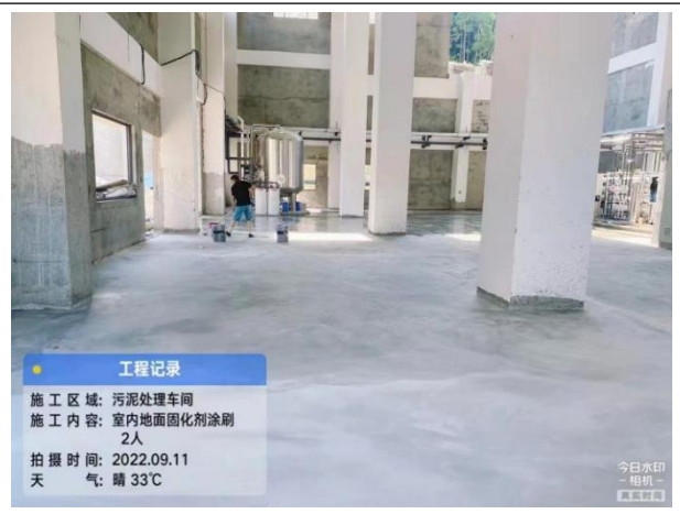
污泥处理车间地面固化
