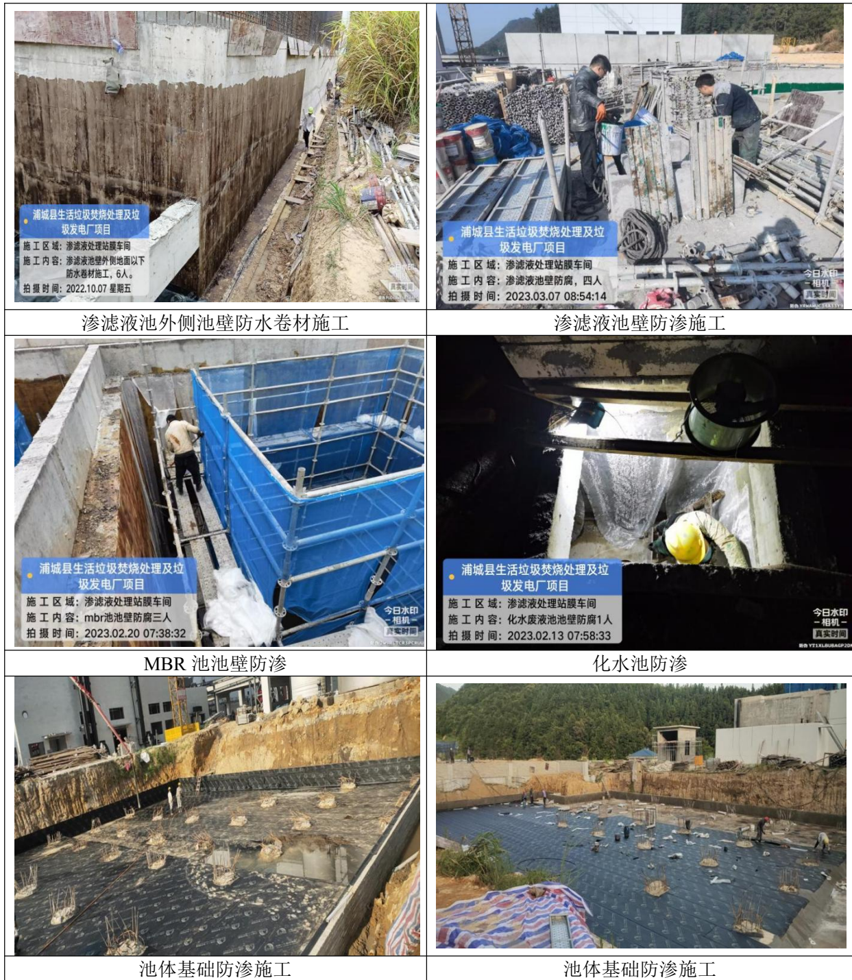
图 4.2-2 防渗的施工图
