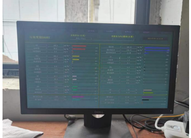
烟气在线监测系统显示屏
