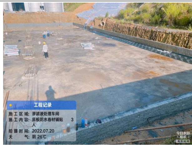
渗滤液池底板防水卷材铺贴
