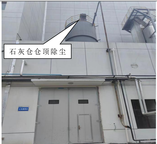
石灰仓（仓顶除尘）
