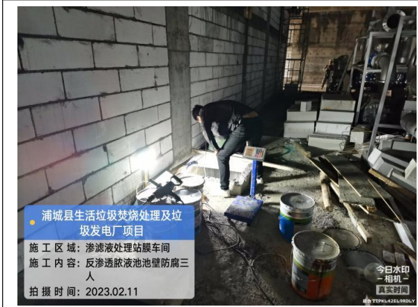
反渗透液池池壁防渗
