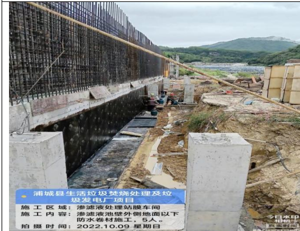
渗滤液池池壁防水卷材铺贴
