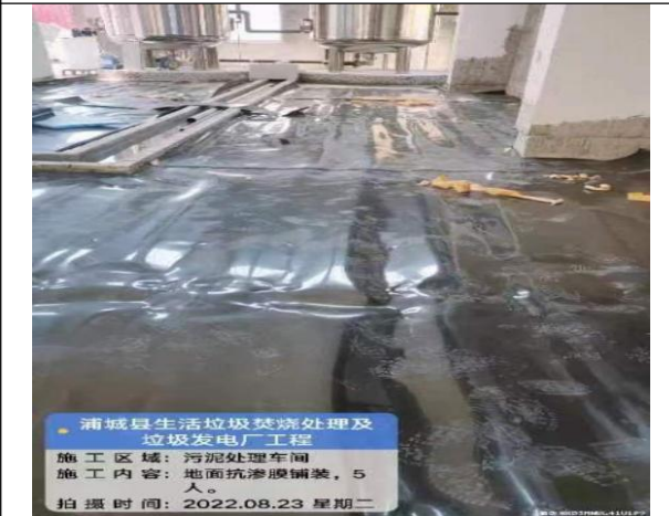
污泥处理车间
