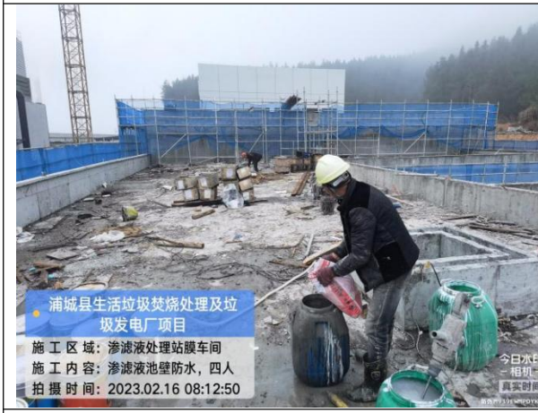
池壁防水施工
